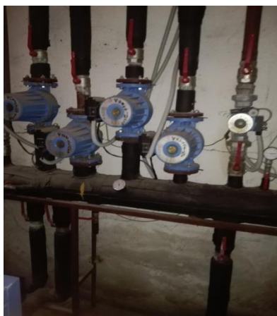
Фиг. 2.2. Отоплителни тела и водоразпределител
